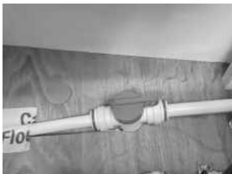
Afb. 91: Klep voor ALDE-vloertemperatuurregeling
