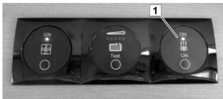
Afb. 133: Aan/uit-schakelaar van de vloerverwarming
