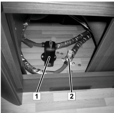
Afb. 106: Aftapkranen TRUMA combi verwarming
