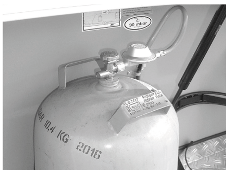
Afb. 77: Gasfles met lagedrukregelaar en lagedrukslang
