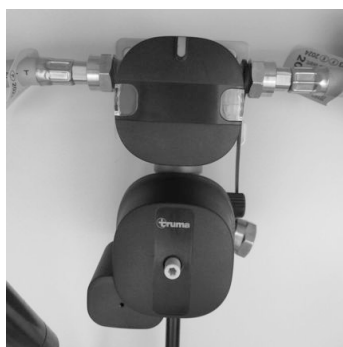
Fig. 109: Gasanolæg DuoControl CS
