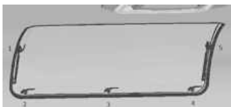
Fig. 37: Indersiden af det hvælvede hængselvindue med fem vridere
