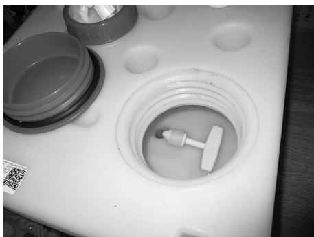
Fig. 95: Bundprop i drikkevandstanken
