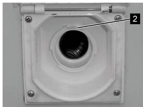
Fig. 102: Påfyldningsstuds for drikkevand, åben
